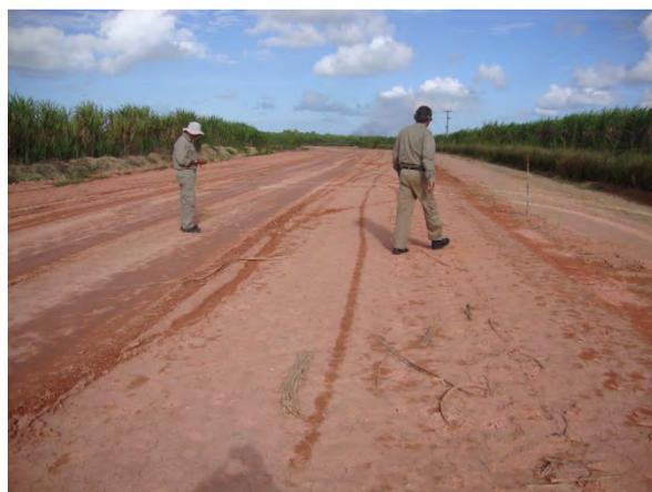
**Figura 18 - Registro da fase de compactação do terreno para pavimentação**
